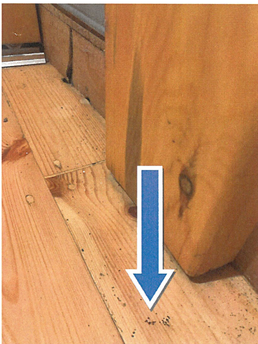
Zdj. 18 i 19 Korozja biologiczna – otwory chodników owadów.
