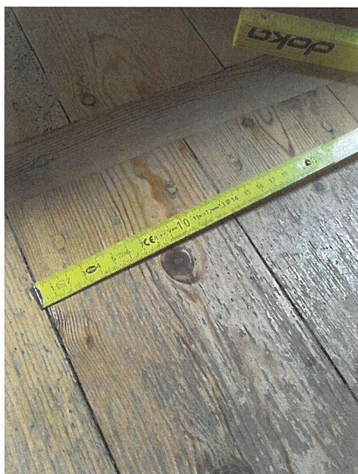
Zdj. 12 Uszkodzenia mechaniczne
