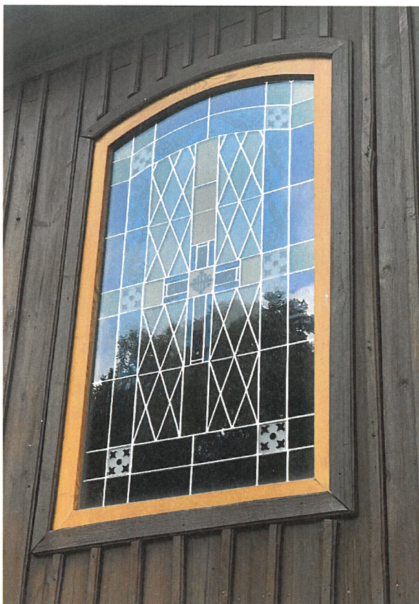
Zdj. 5 Stolarka okienna po remoncie w 2017r.
