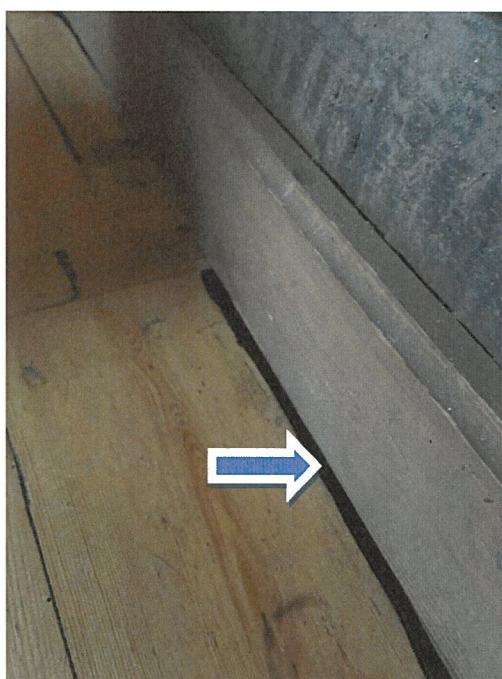
Zdj. 13 Szczelina wentylacyjna
